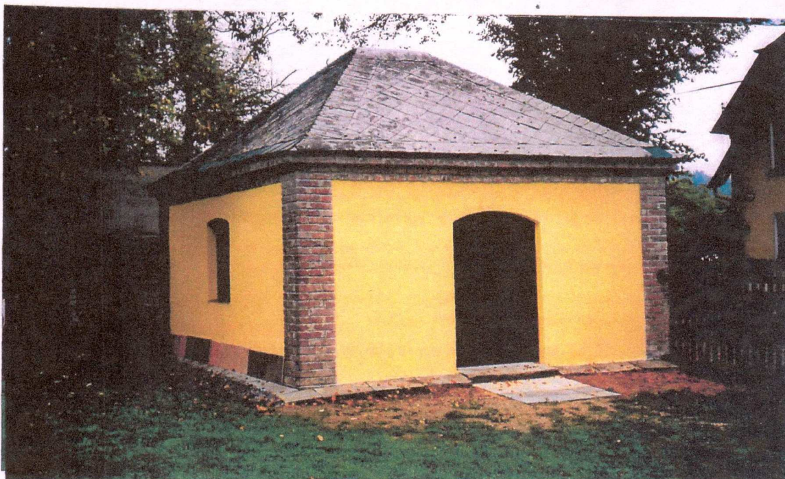
Das von Fa. Ladislav Balšan erneuerte Friedhofs= haus
