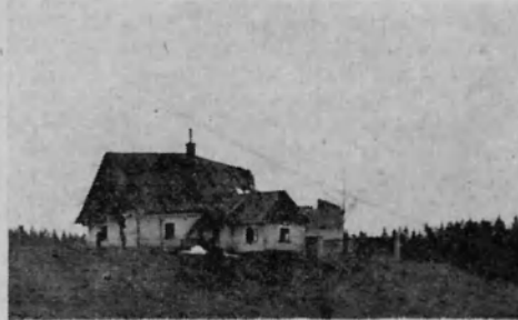
5. Zum Teil abgetragen hat man das einstmalig schmucke Bauernhäuschen Burucker auf der Prex. Es steht leer und macht einen gespenstischen Eindruck.
