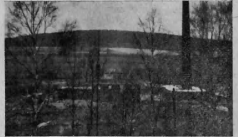
6. Völlig gesprengt ist die Feig's-Zügelhütte. Auch der Schornstein wurde schon angebohrt. Doch wegen der unmittelbaren Nähe des Hauses „Waldfrieden“ verboten bisher die Amerikaner die Sprengung.
