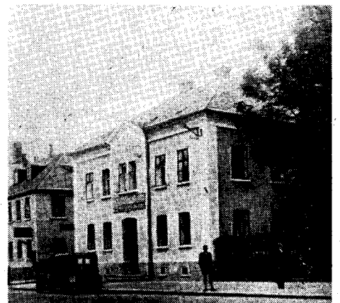
Volkshaus vor dem Umbau
