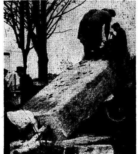
zweiten Oktoberhälfte wurde dieser 20 t schwere Granitfindling von der Kösseine angefahren: 6 Meter hoch, 1 Meter breit und 80 cm tief. Die Aufstellung des Steines auf dem vorbereiteten Beton-Fundament war eine schwierige Arbeit, die von einem Kirchenlamitzer Granitwerk mit Hilfe von Raupen, Winden und Flaschenzügen bewerkstelligt wurde. Anschließend ging es an die gärtnerische Ausgestaltung. Am Totensonntag, den 20. November, wird die Weihe der neuen Anlage erfolgen.
