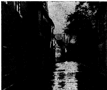
Das konnte vor der Kanalisierung in Asch passieren: Überschwemmte Rosmaringasse
