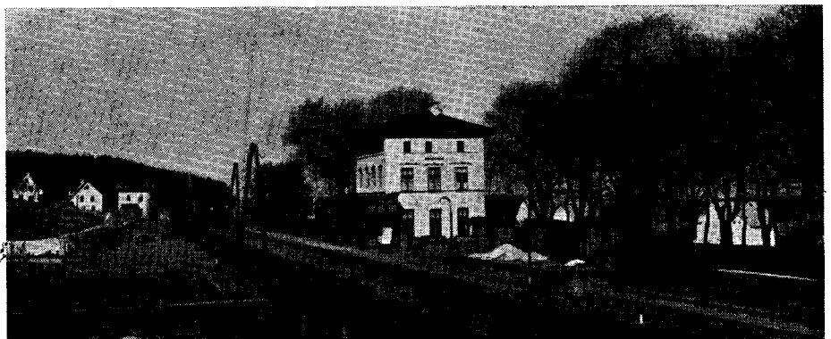
An der Strecke Eger-Hof: Bahnhof Haslau
