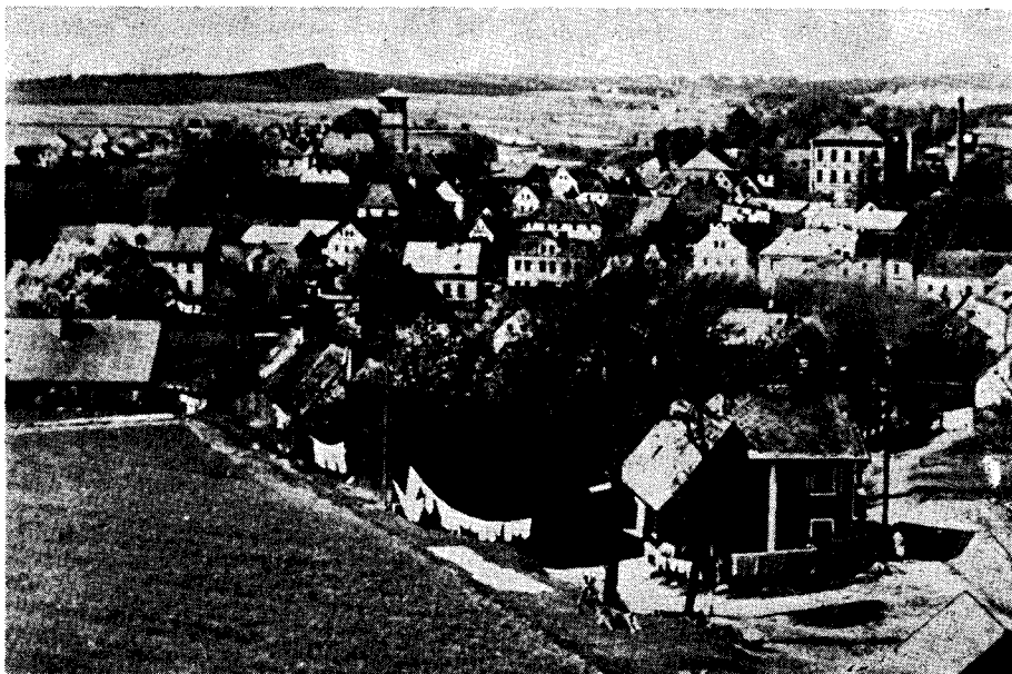
Gesamtaufnahme von Haslau
