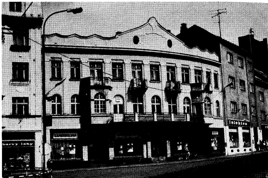
Das Café Geyer, aufgenommen Pfingsten 1986. Die Fassade ist in gutem Zustand. Wären nicht die tschechischen Schilder in den Fenstern, könnte man sagen: fast wie früher.
