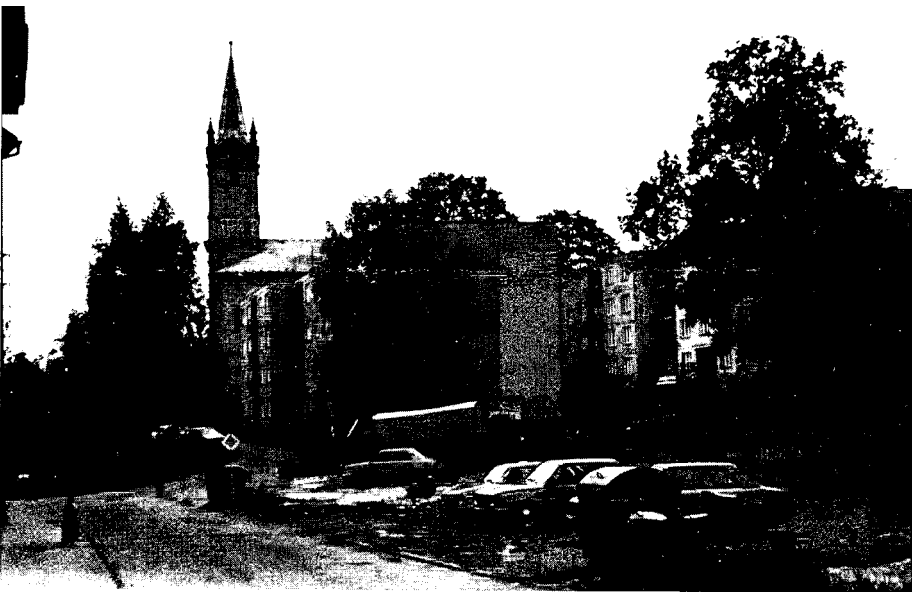
Die Fabrikgebäude Klaubert und Glässel sind abgerissen, die Grundstücke dienen als Parkplätze. In der Bildmitte und rechts Mietshäuser, die bis an die katholische Kirche heranreichen.
