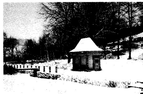
Das Häuschen am Überlauf
