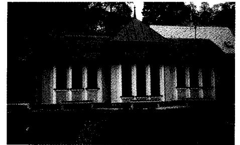
Das Niederreuther Quellhäuschen nach der Renovierung 1991 mit drei neuen Ruhebänken an der Westseite. Foto: Hermann Heinrich jun.
