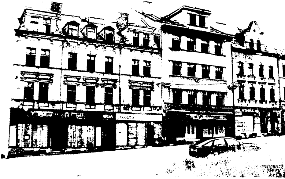
Die „Trotz-Häuser“ werden bald nicht mehr sein. Überall zeigt sich der Verfall.
