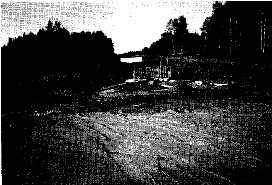
Zwischen den Einschaltungen der beiden Betonpfeiler verläuft die Bahnlinie
