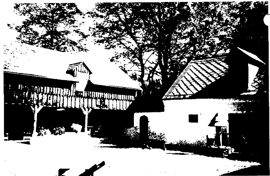
Das Forstanwesen Reinel mit Nebengebäude und Hofraum
