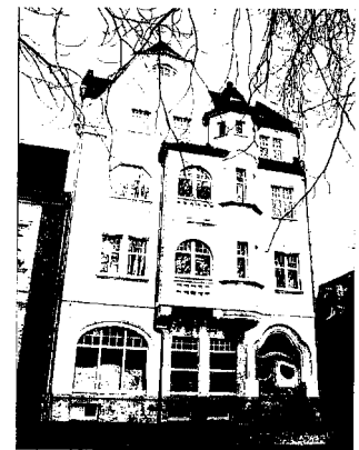
Das Gebäude, in dem sich das neue Archiv befindet.
