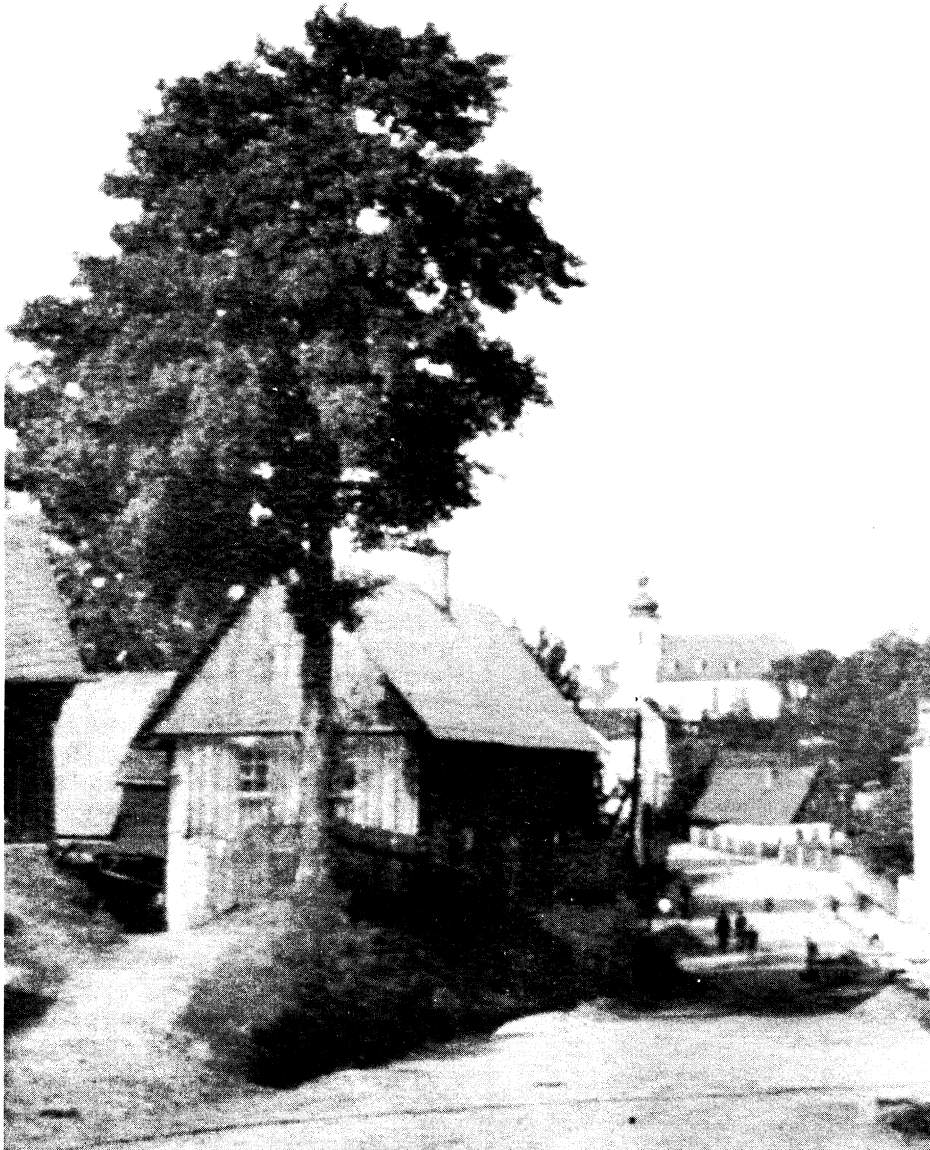
Blick von der Ascher Straße vor der Bahnunterführung auf die evangelische Kirche. Rechts Schnaps-Richter. Die anderen Häuser stehen alle nicht mehr.
