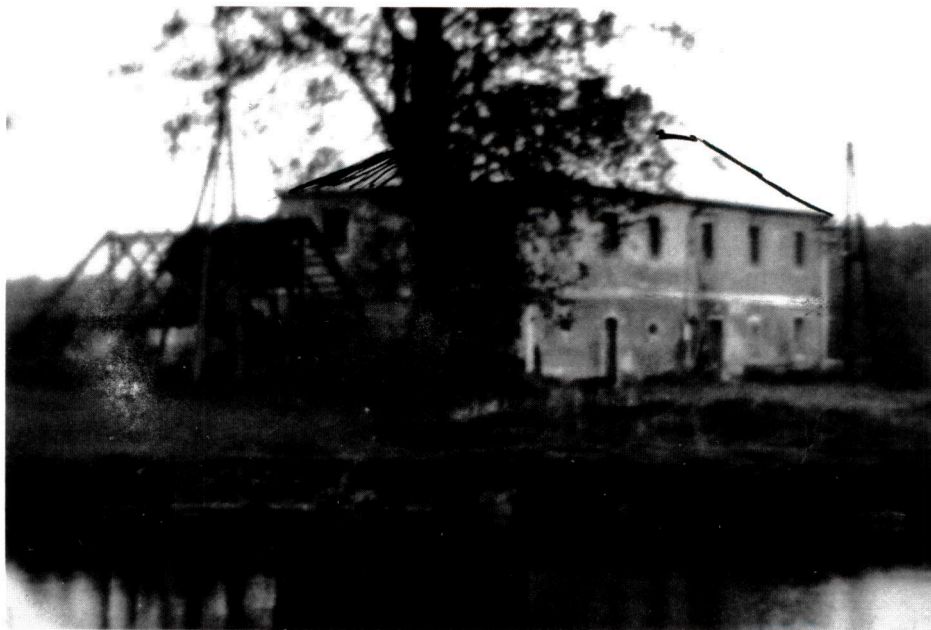
Das Wernersreuther „Schloss“, ein Zedtwitzisches „Vorwerk“, kurz vor seinem Abbruch (um 1960).
