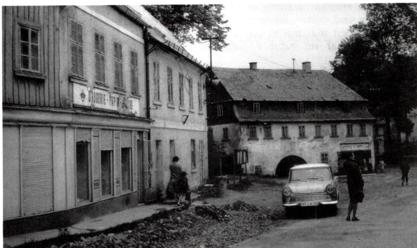
Diese Aufnahme aus dem Jahr 1965 lässt schon den Verfall erkennen, aber das Untere Wirtshaus stand noch, ebenso die Häuser Hofmann und Egelkraut. Seit Jahren ist aber nichts mehr davon vorhanden.
