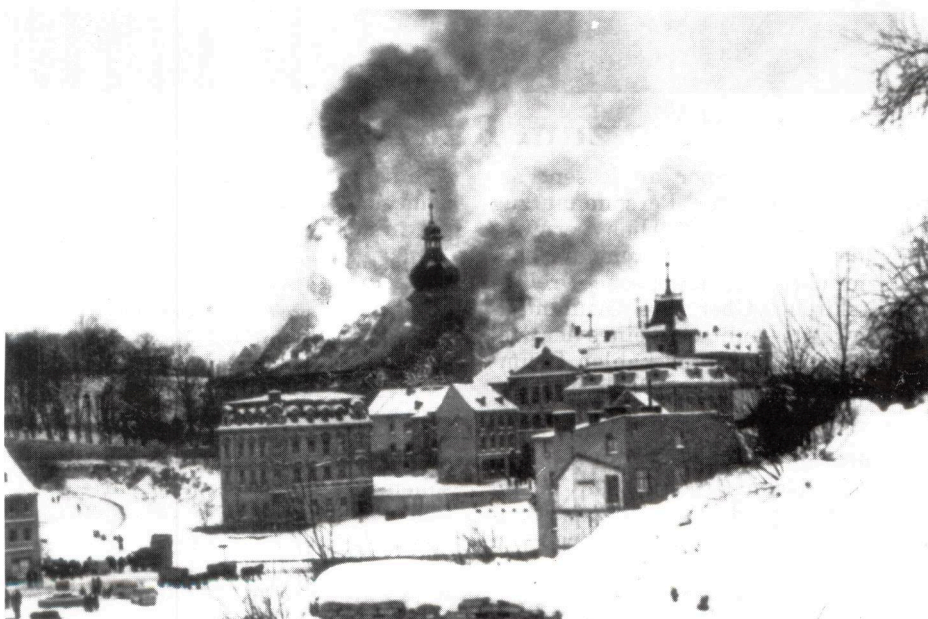
Rauchschwaden während des Brandes
