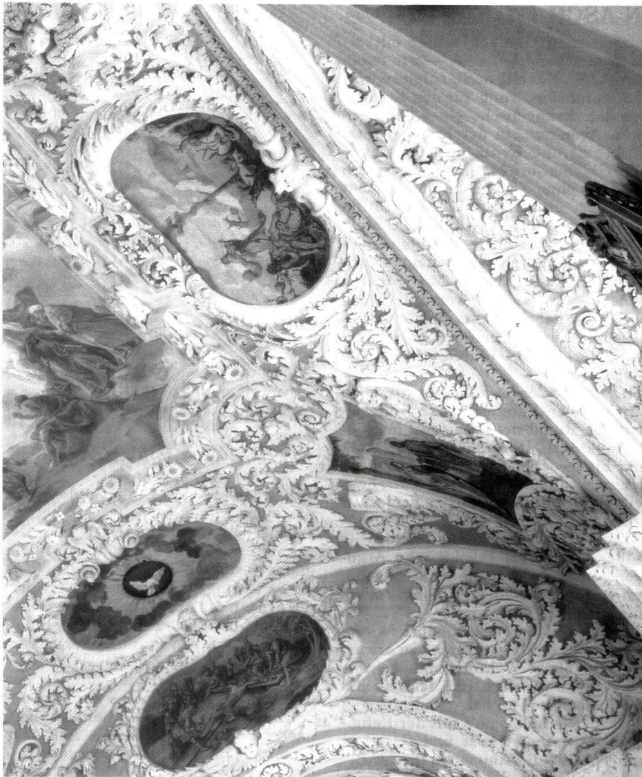
Wallfahrtskirche „Zur Schmerzhafte Gottesmutter“ in Vilgertshofen: Teilansicht vom plastisch ‚greifbaren‘ Stuck der Wessobrunner Schule.
