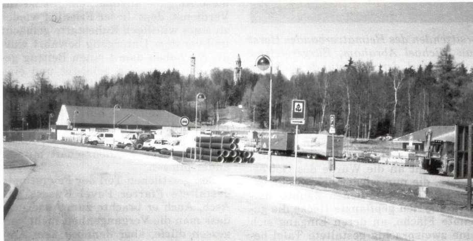
Großbaustelle am Hainberg
