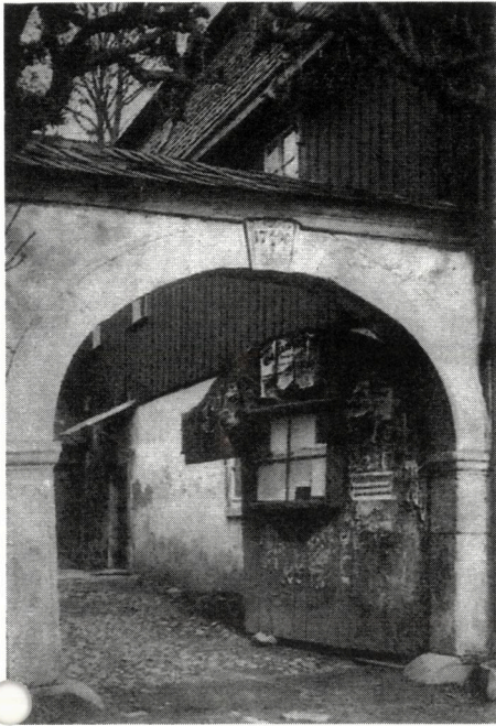
Die „Alte Post“ in Roßbach, Haus Nr. 44 an der Hauptstraße
