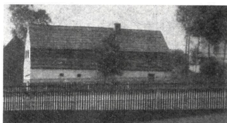
Den Panzer-Hof haben die Tschechen 1947 abgerissen.
