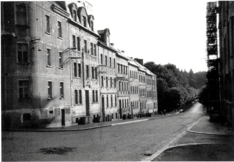
Ringstraße zwischen Jahn- und Kegelgasse, 1966.
