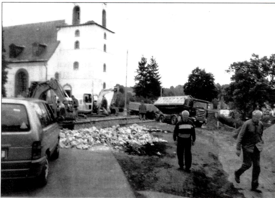
Horst Künzel und Gerhard Schmidt begutachten die Arbeiten auf dem Kirchplatz. Hier soll ein Brunnen hinkommen.
