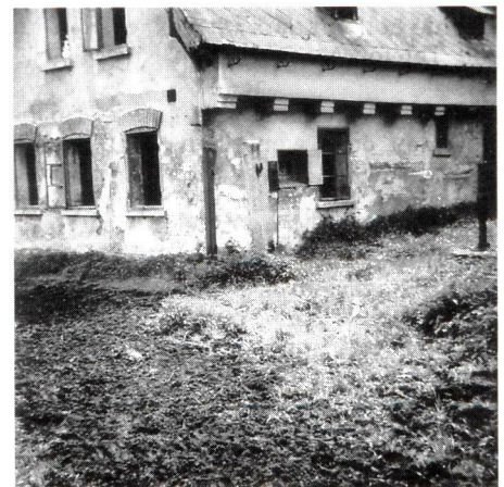
Längere Zeit war die Knöckelmühle dem Verfall preisgegeben, bevor der jetzige Inhaber renovierte. Auf diesem Bild ist die Schiefereindeckung der ehemaligen Schindelmühle zu erkennen.
