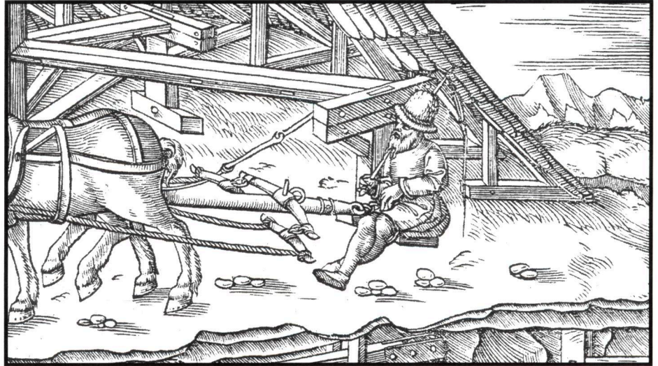
Perfektionierter Göpel (aus: Agricola, Vom Bergwerck)
