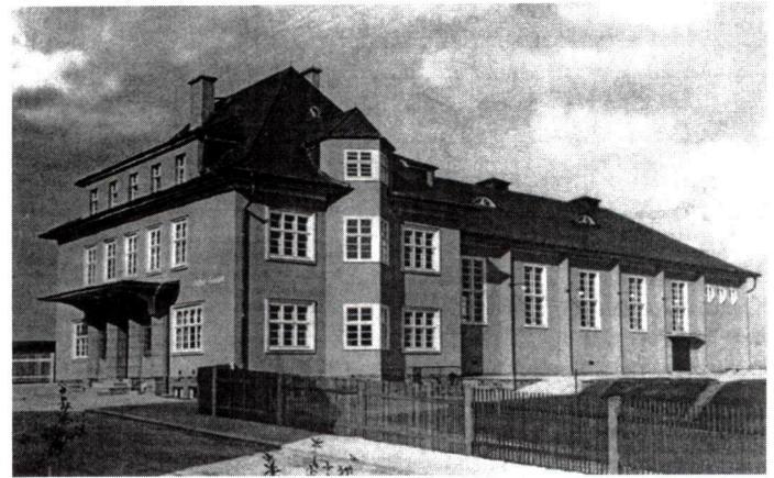
Nach der Fertigstellung im Juli 1933
