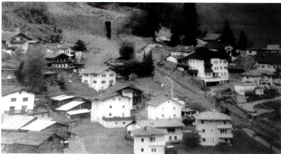
Schlammlawine in See. Links: Ortsteil Schaller, rechts: Ortsteil Gries, mitte: Schallerbach. (Hier geht der Fußweg zur Ascher Hütte.)
