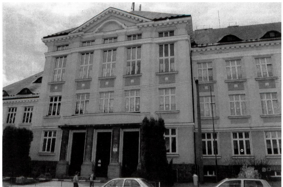
Ascher Gymnasium (jetzt Grundschule) gut erhalten im Mai 2015
