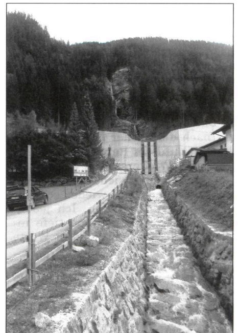
Neuer Schutzwall am Schallerbach unterhalb des Wasserfalls in See.
