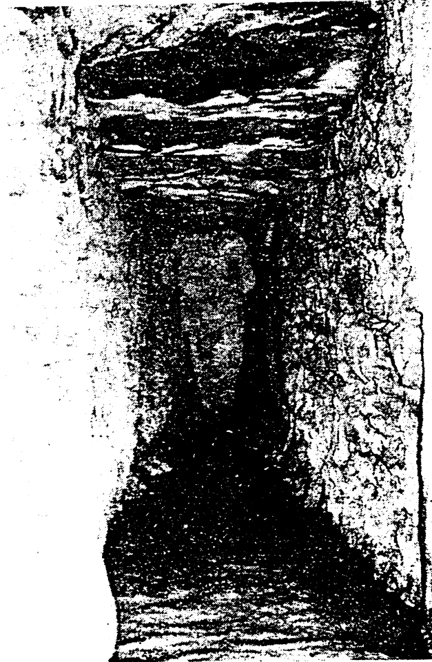
Abb. 2: Ein Teil des Stollenanfangs (Wildenau) ist mit schweren Granitplatten abgedeckt. Der Kanat wird an diesem Punkt von der Bahnlinie Hof-Asch geschnitten.
